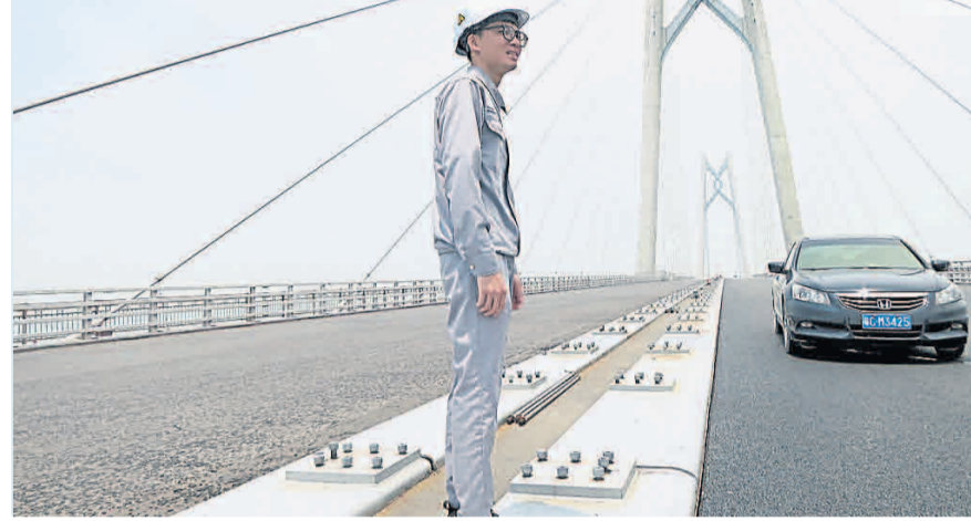
港珠澳大橋香港段2012年中動工，連接港珠澳大橋主橋及香港口岸，全長共12公里，包括9.4公里長的高架橋段、1公里長的景觀山隧道段，以及1.6公里長沿機場東岸以填海造地建成的地面道路，是全球既有橋梁又有海底隧道的龐大工程之一。據報，這座世界最長的跨海大橋，可望于年底全面通車。(路透社照片)
